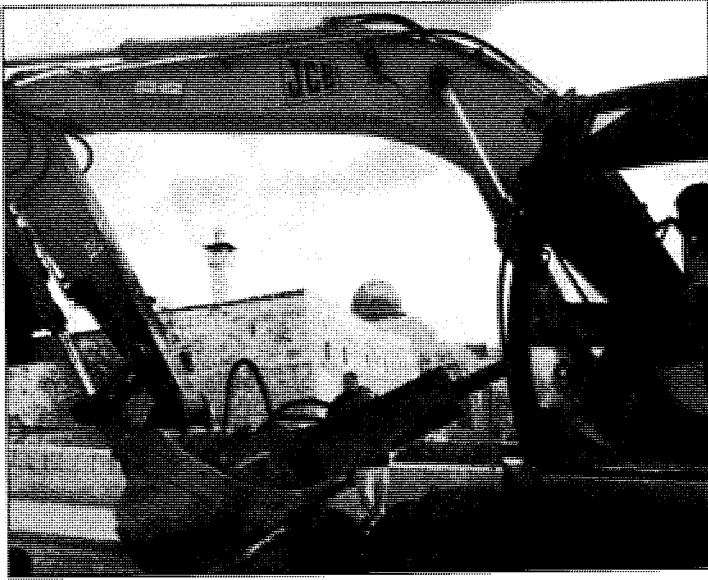
توضيح خطورة حفريات وأنفاق الصهاينة تحت المسجد الأقصى
